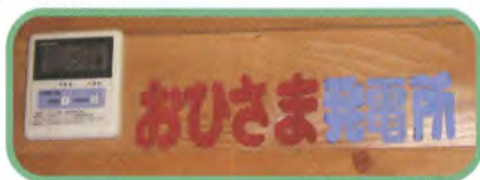
発電量表示板
