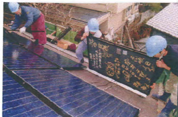
太陽光パネルの設置
