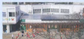
かがやきおひさま発電所
