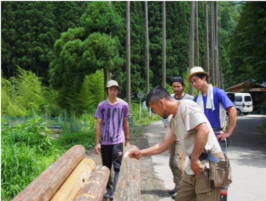
東屋を建設中
