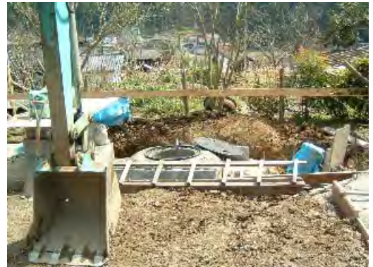
写真1--施工中のメタン発酵槽と液肥汲み取り槽
