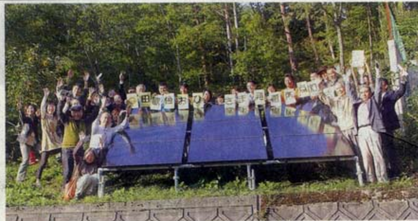
2012年10月に南丹市美山町に設置された「おひさま発電所」
