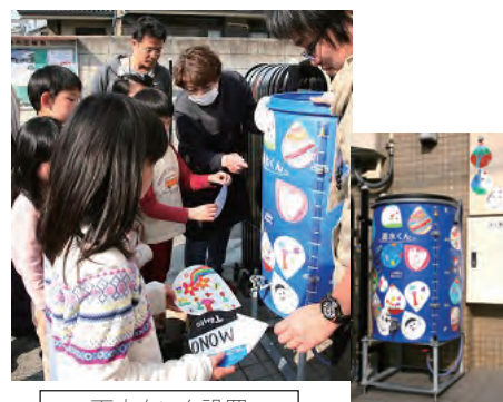
雨水タンク設置
